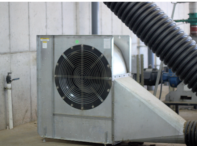
Ventiladores centrífugos para disminuir el contenido en humedad de los SER
