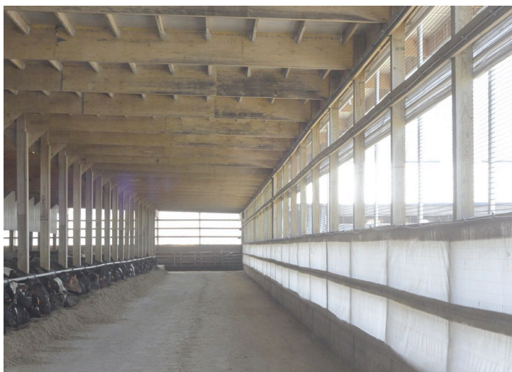
Fotografía 7. Vista interior de la pared lateral de entrada de aire. Dispone de dos líneas de microdifusores
