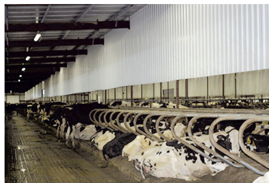
Fotografía 1. Cortinas metálicas situadas entre dos filas de cubículos
