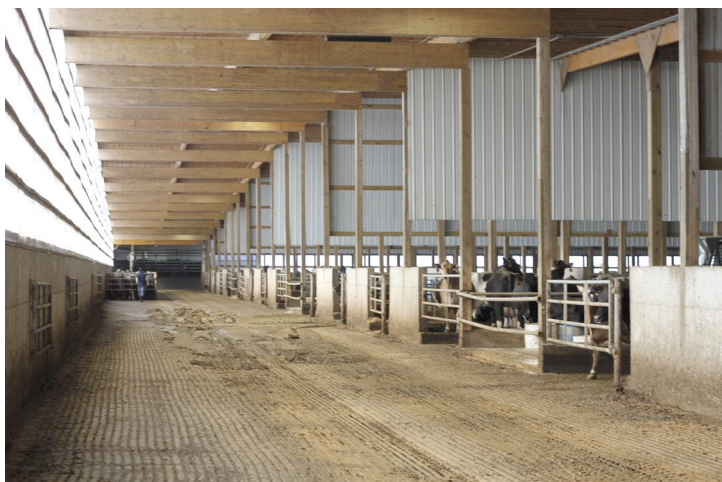
Fotografía 9. Pasillo transversal que comunica los corrales con la sala de ordeño
