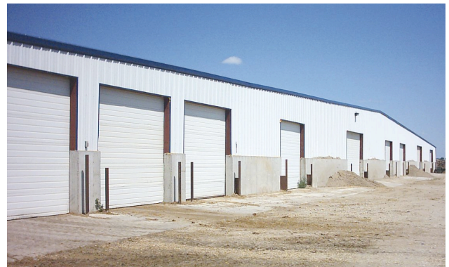
Fotografía 5. Vista frontal de un edificio VCPB con 18 filas de cubículos
