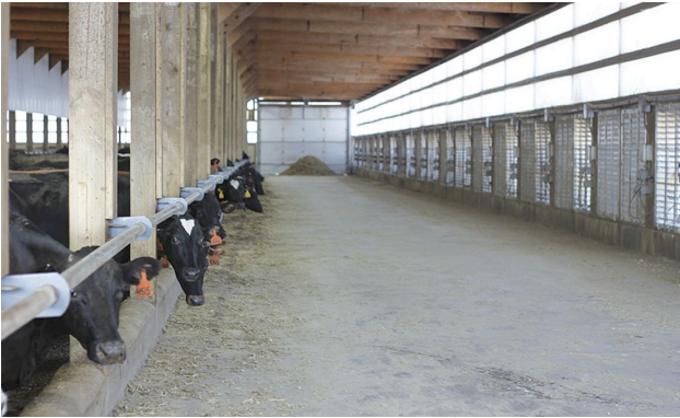
Fotografía 2. Vista interior de la pared lateral compuesta de ventiladores
